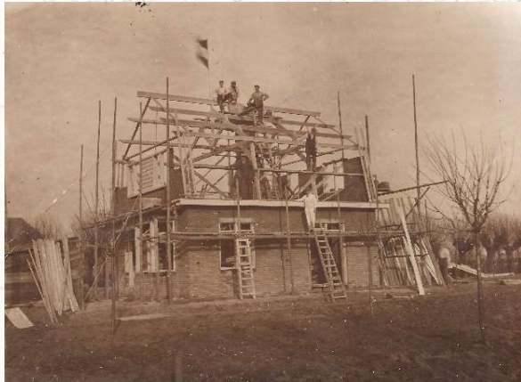
Afb. 1. Nijburgse straat 55 Randwijk in aanbouw. Foto in bezit van Theo de Ruijter.
